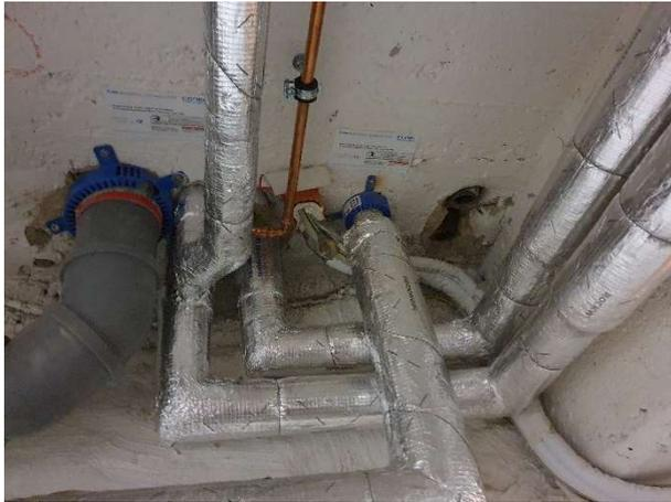
Abstandsregel. Systeme, deren Grundlage ein abP ist, werden von einer MPA herausgegeben. Ein abP kann sowohl die MLAR-Regel mit  $\geq 50$  mm als auch die DIBt-Regel mit  $\geq 100$  mm oder  $\geq 200$  mm beinhalten. Im konkreten Fall sollte die Belegung geplant werden. Die Methode, wer zuerst kommt malt zuerst, kostet unnötig Installationsraum und birgt Ausführungsfehler. Auch wenn die Einzelausführung zulässig ist, kann die Gesamtanordnung falsch sein.
